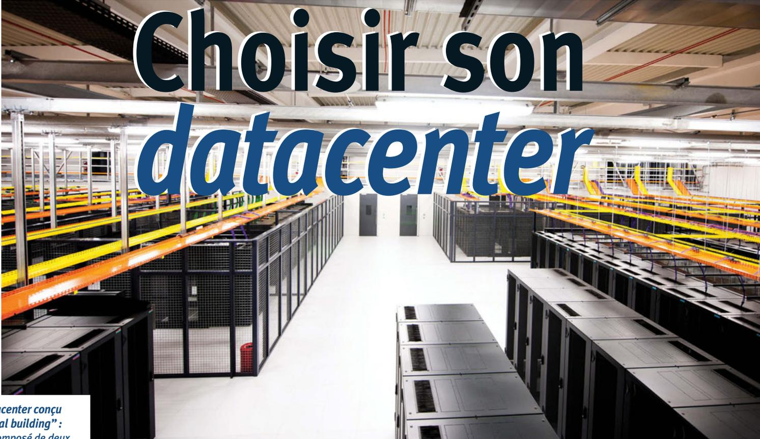
► **Datacenter conçu en "dual building" :** il est composé de deux salles d'hébergement totalement indépendantes électriquement et séparées par un mur coupe-feu 2h permettant de réaliser PCA et PRA au sein d'un même centre (Data center Tier IV "Paris 3-Condorcet" de TeleticityGroup).
